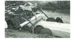
テープシーダーを取り付けている作業
